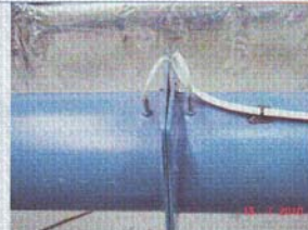
Brida lista para recibir la Placa Orificio
